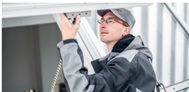
Überprüfung des Motoröffners
