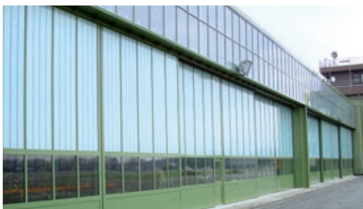
Aluminium-Schiebetoranlage 70,0 x 6,5 m
