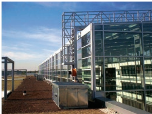
Einsatz einer Befahranlage
