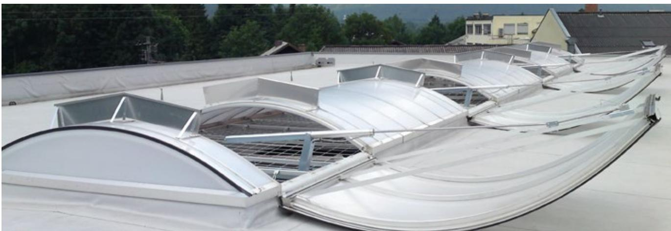
JET-VARIO-FIREJET® 165 J AZ und JET-VARIO-FIREJET® 165 J 24/48V AZ sind RWA-Geräte für einen effektiven Rauch- und Wärmeabzug nach DIN EN 12101-2 mit der Funktion Auf/Zu
