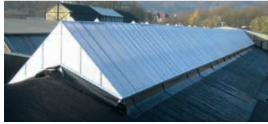
Sávós felülvilágító felújítás után
