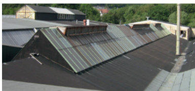
Pasma świetlne ze szkła zbrojonego przed modernizacją
