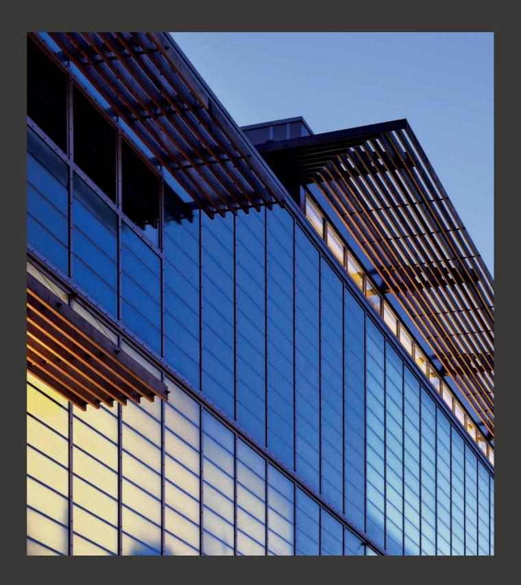
Als sinnvolle und robuste Alternative zu Glaskonstruktionen bieten sich Lichtfassaden aus GRILLODUR® an. Sie zeichnen sich durch hohe mechanische Belastbarkeit aus und sind beispielsweise absolut ballwurfsicher bis hin zur Hockeyballsicherheit. Damit sind die GRILLODUR® Elemente den harten Anforderungen des Alltags gewachsen und gewährleisten eine lange Nutzungszeit.
